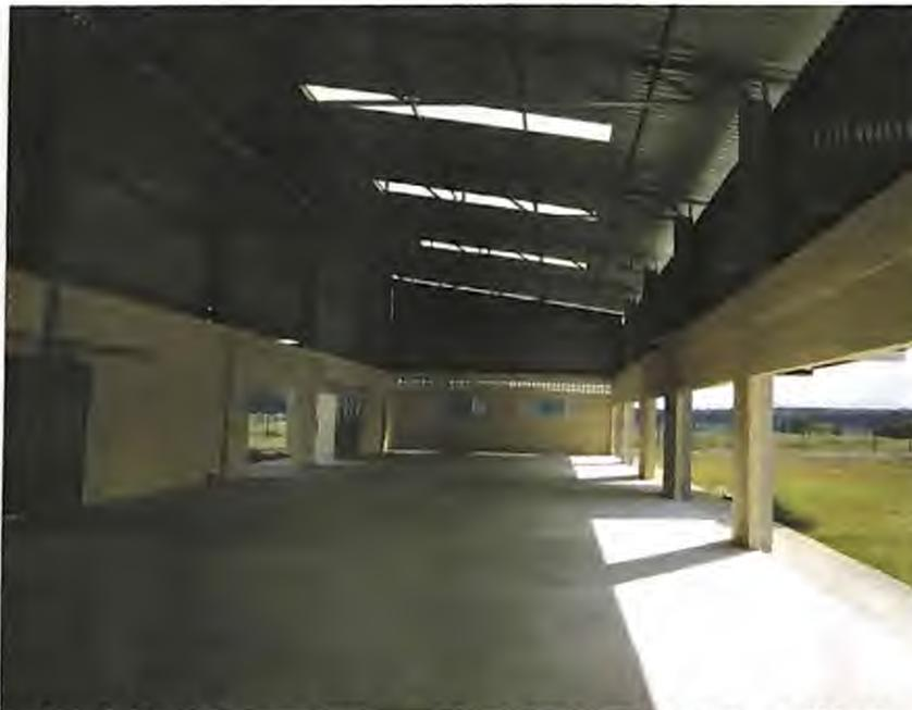
IMAGEM 10- Tesouras, terças, fechamento lateral e telhas metálicas
