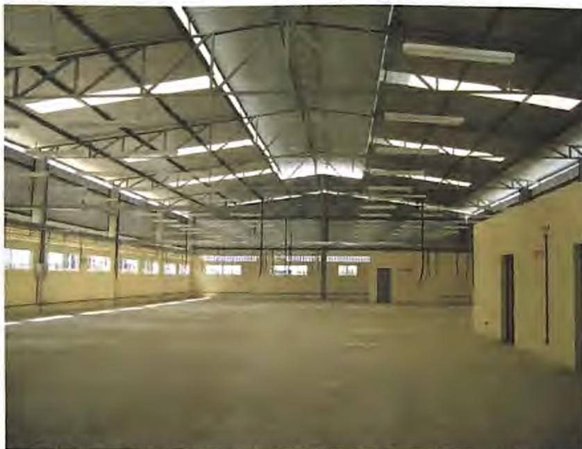
IMAGEM 7- Tesouras, terças, fechamento lateral e telhas metálicas
