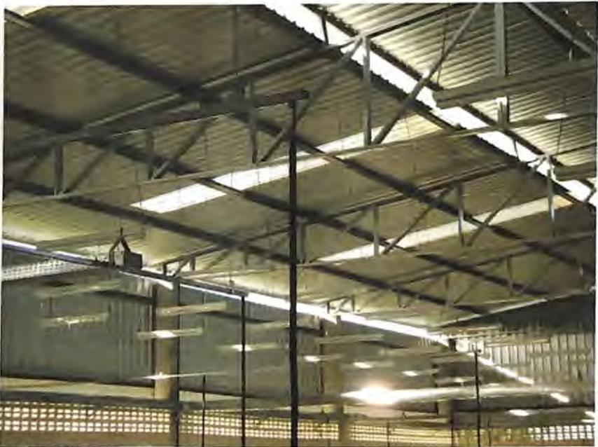
IMAGEM 6- Tesouras, terças, fechamento lateral e telhas metálicas
