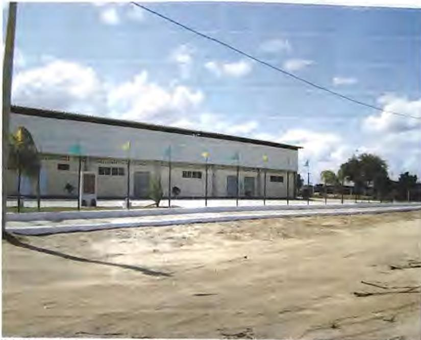
IMAGEM 13- Fechamento lateral e cobertura – estrutura e telhas metálicas
