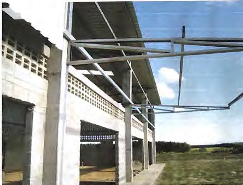
**IMAGEM 12- Tesouras, terças, fechamento lateral - estrutura e telhas metálicas**
