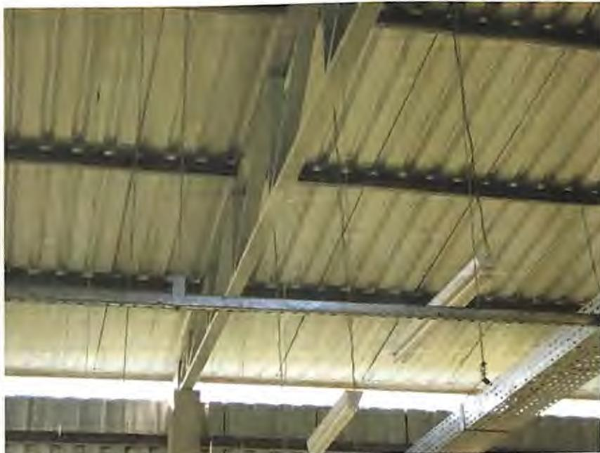
IMAGEM 5- Tesouras, terças e telhas metálicas
