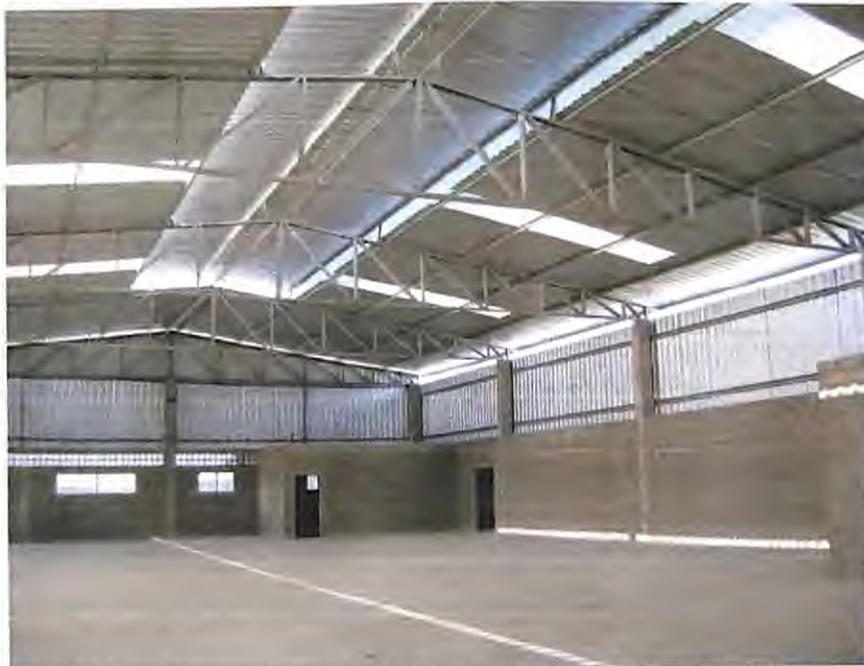
**IMAGEM 11- Tesouras, terças, fechamento lateral e telhas metálicas**
