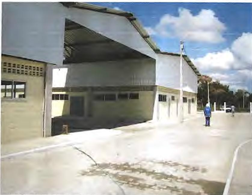
IMAGEM 8- Tesouras, terças, fechamento lateral e telhas metálicas
