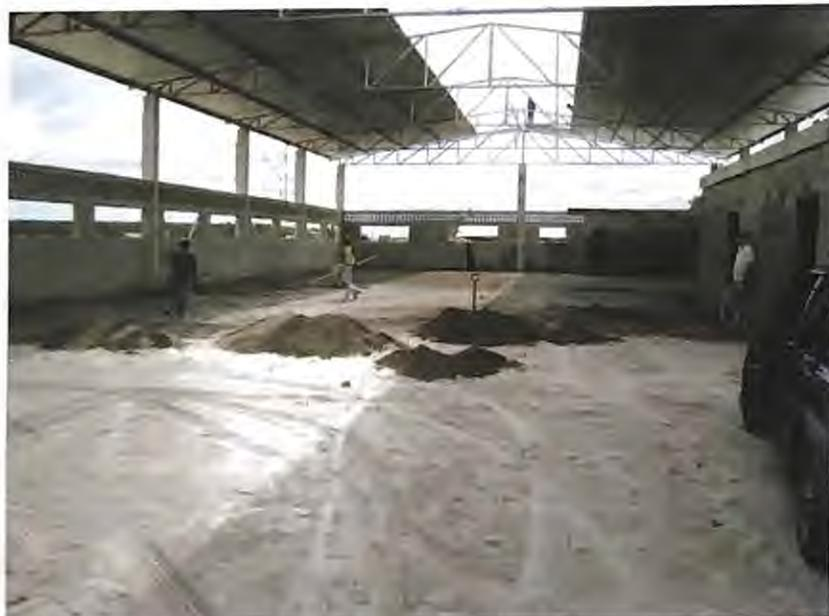
**IMAGEM 2- Tesouras, terças e telhas metálicas**
