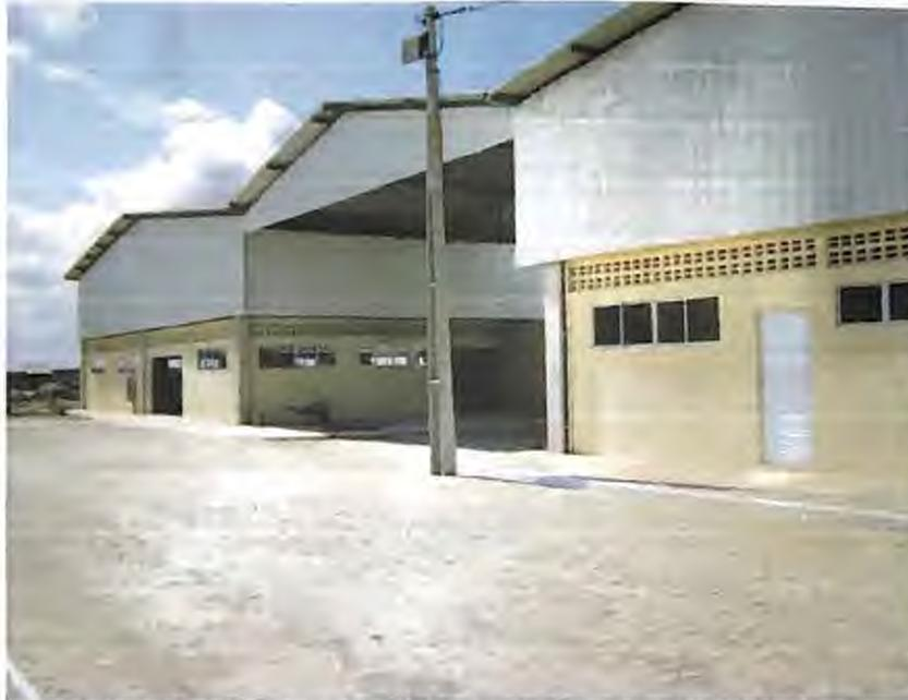
IMAGEM 9- Tesouras, terças, fechamento lateral e telhas metálicas
