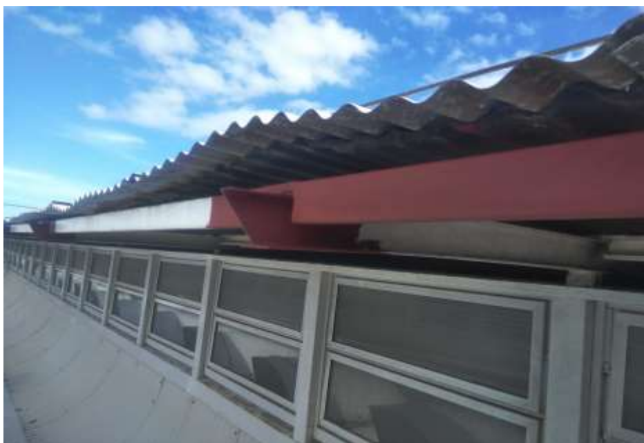
Imagem 21: serviço de recuperação de terças e extremo de vigas da cobertura em execução pela manutenção
