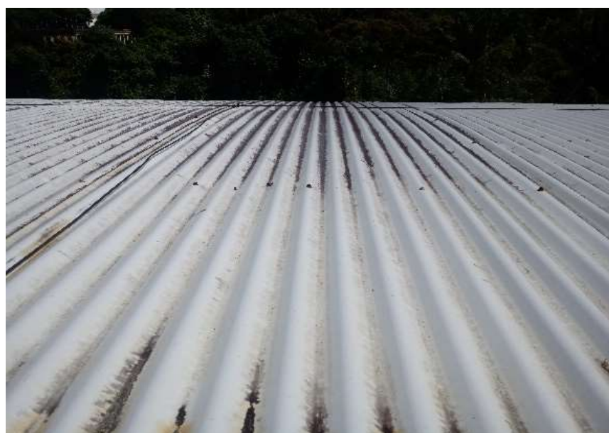
Imagem 9.1 – telha da cobertura
