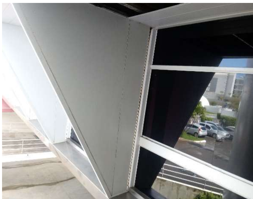
imagem 11 – septos e esquadrias de fachada
