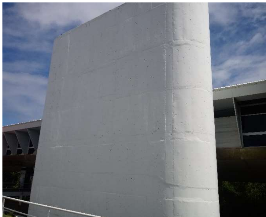
Imagem 18 – torre de escada e elevador
