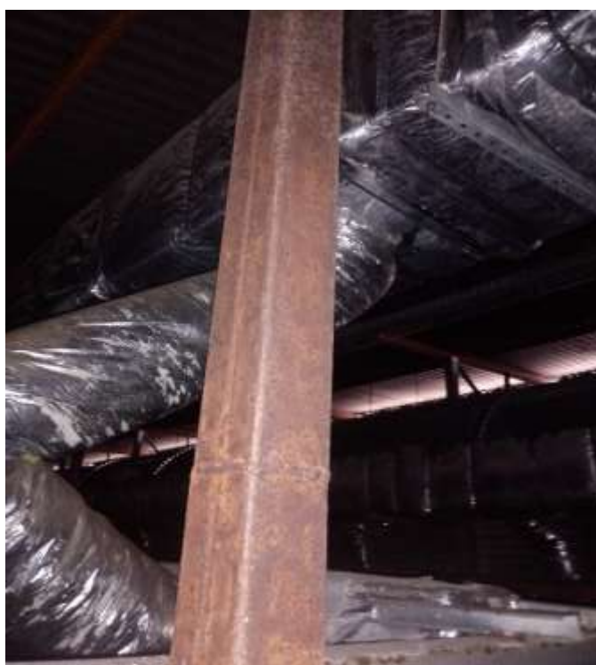
Imagem 8 – montantes das vigas
