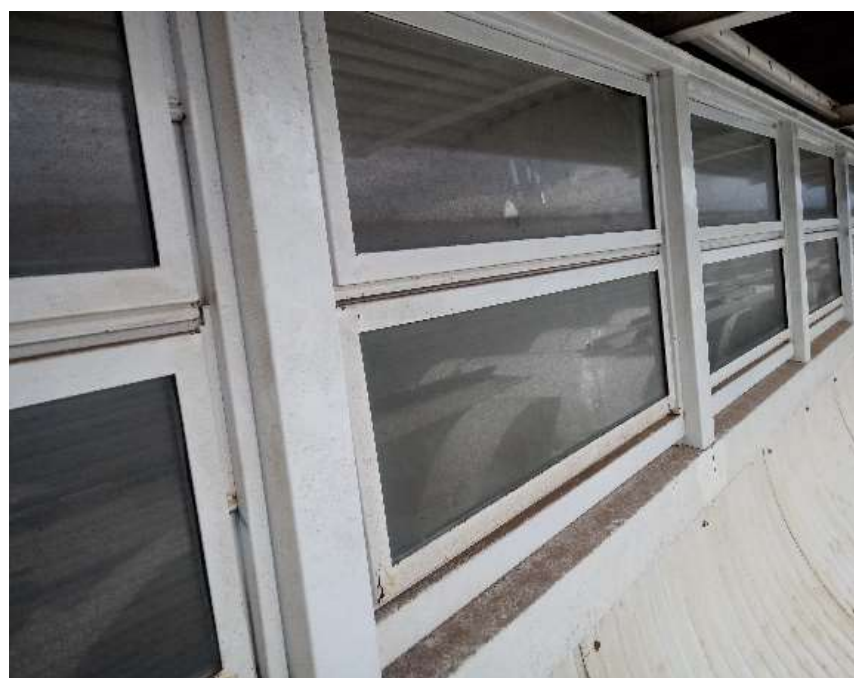
Imagem 13 – esquadrias do shed interno
