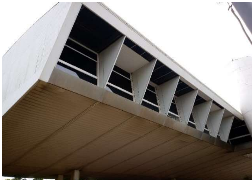
Imagem 10 – vista de fachada e esquadrias
