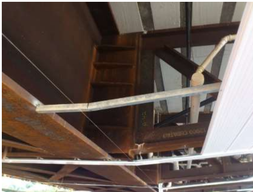
Imagem 5 – junção viga com treliça
