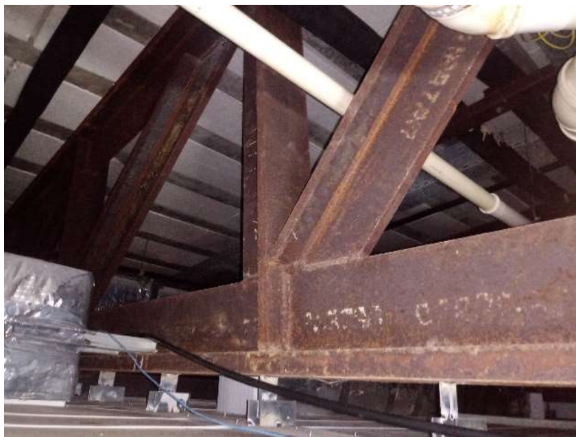
Imagem 6 – vista parte da treliça
