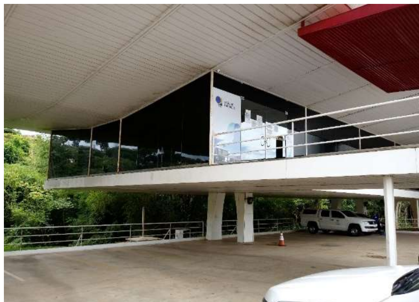
Imagem 15 – vista lateral do mezanino
