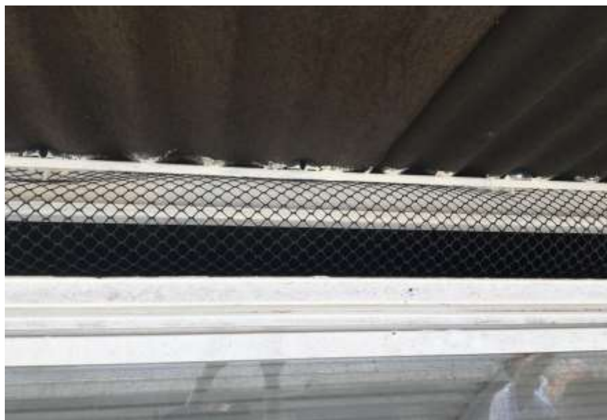
Imagem 9 – terças da cobertura
