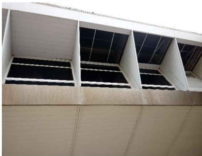
Imagem 12 – arremates superiores e inferiores de fachada
