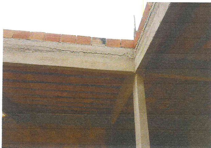
Figura 06 – Pilares e vigas bem executadas, aspecto liso, demonstra que não houve segregação do concreto durante a concretagem.
