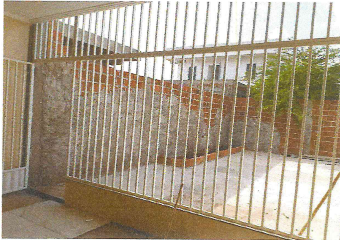
Figura 17 – Área de serviço e quintal (duas fileiras de cerâmica foram retiradas para ajustar tubulação de esgoto, isto é, melhorar sua inclinação).
