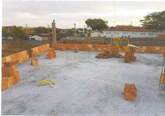
Figura 02 - Marcação de alvenaria – 1º andar
