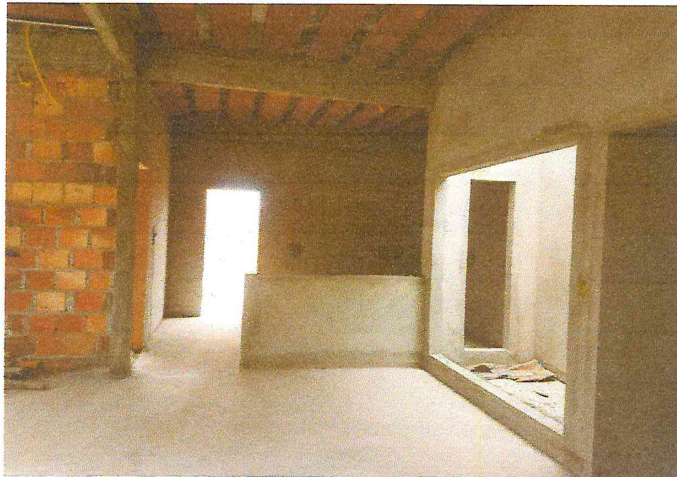
Figura 05 – Contrapiso em bom aspecto e revestimento argamassado nas alvenarias com um bom acabamento
