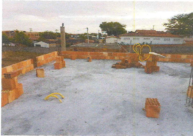
Figura 02 - Marcação de alvenaria – 1º andar
