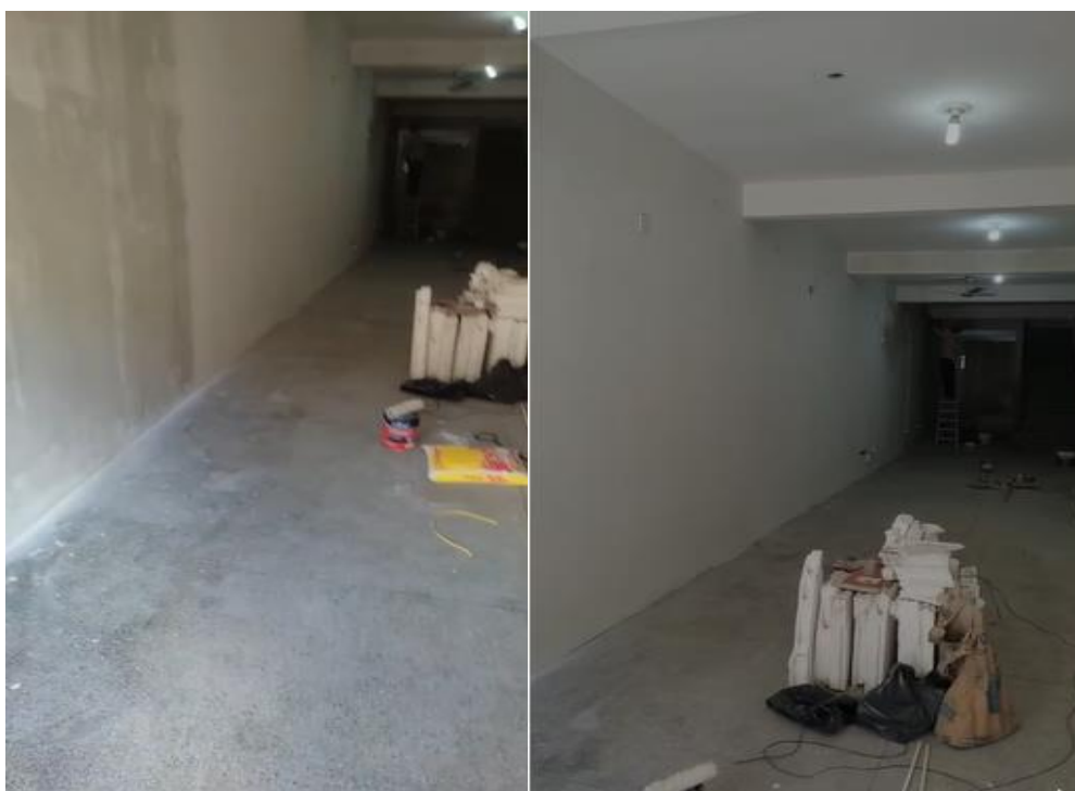
Figuras 12 e 13 – Serviço de acabamento - pintura
