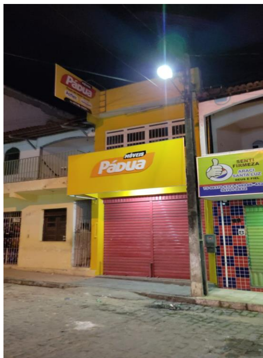
Figura 15 – Fachada, após finalização da obra.
