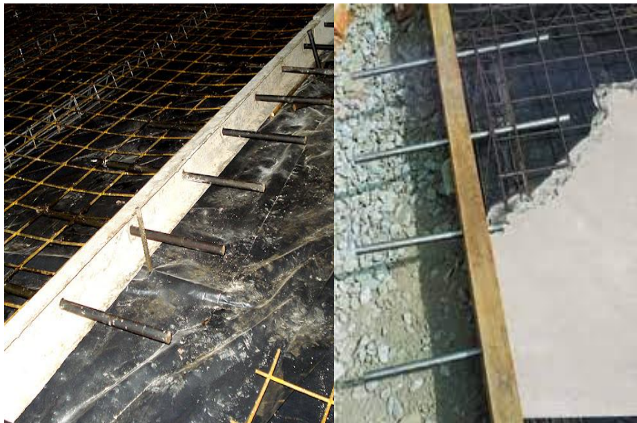
Figuras 06 e 07 – Detalhe da execução do piso industrial
