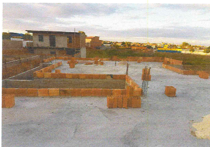
Figura 01 – Finalização de laje pré-moldada e capa de concreto armado
