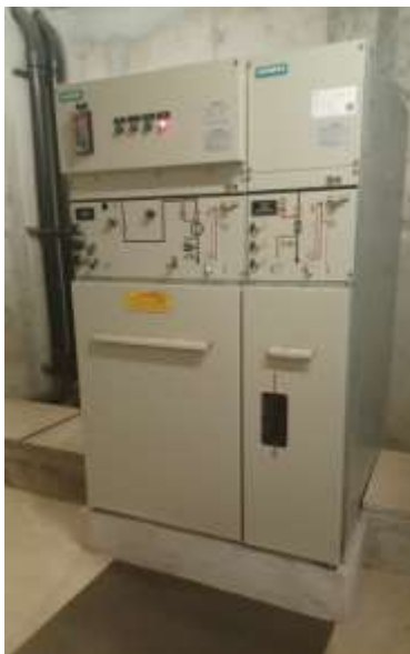
Painel de média existente que alimenta o transformador de 500 kVA.
